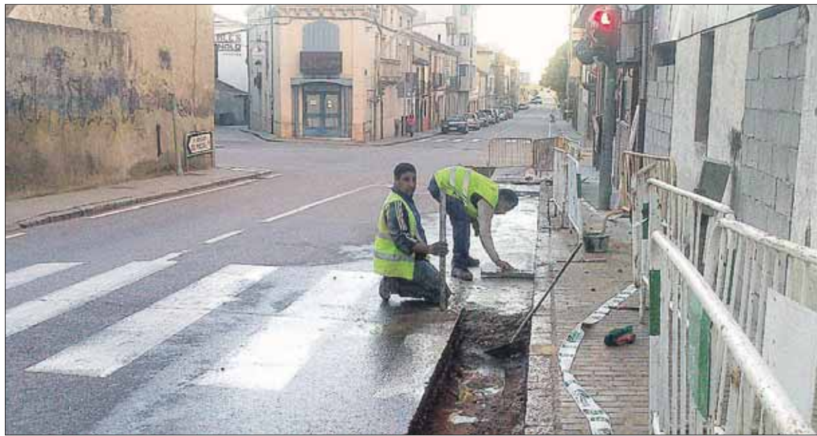
Varios operarios trabajan en las obras de canalización del gas junto al cruce de carreteras CL-603 y SG-205. / EL ADELANTADO
