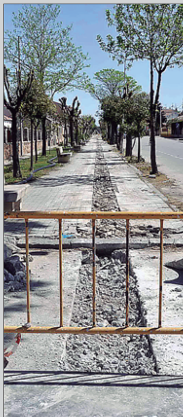
Mejora de una red de agua.
