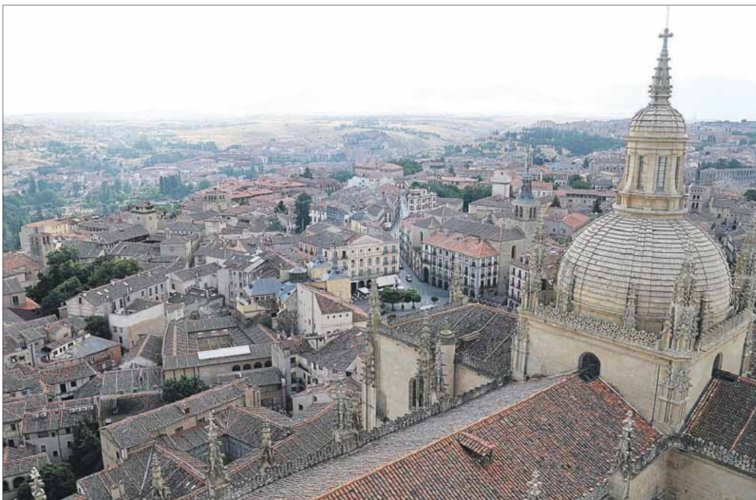
Imagen aérea de la seo segoviana. Las obras permitirán reparar las cubiertas de las naves centrales del templo. / JUAN MARTÍN
