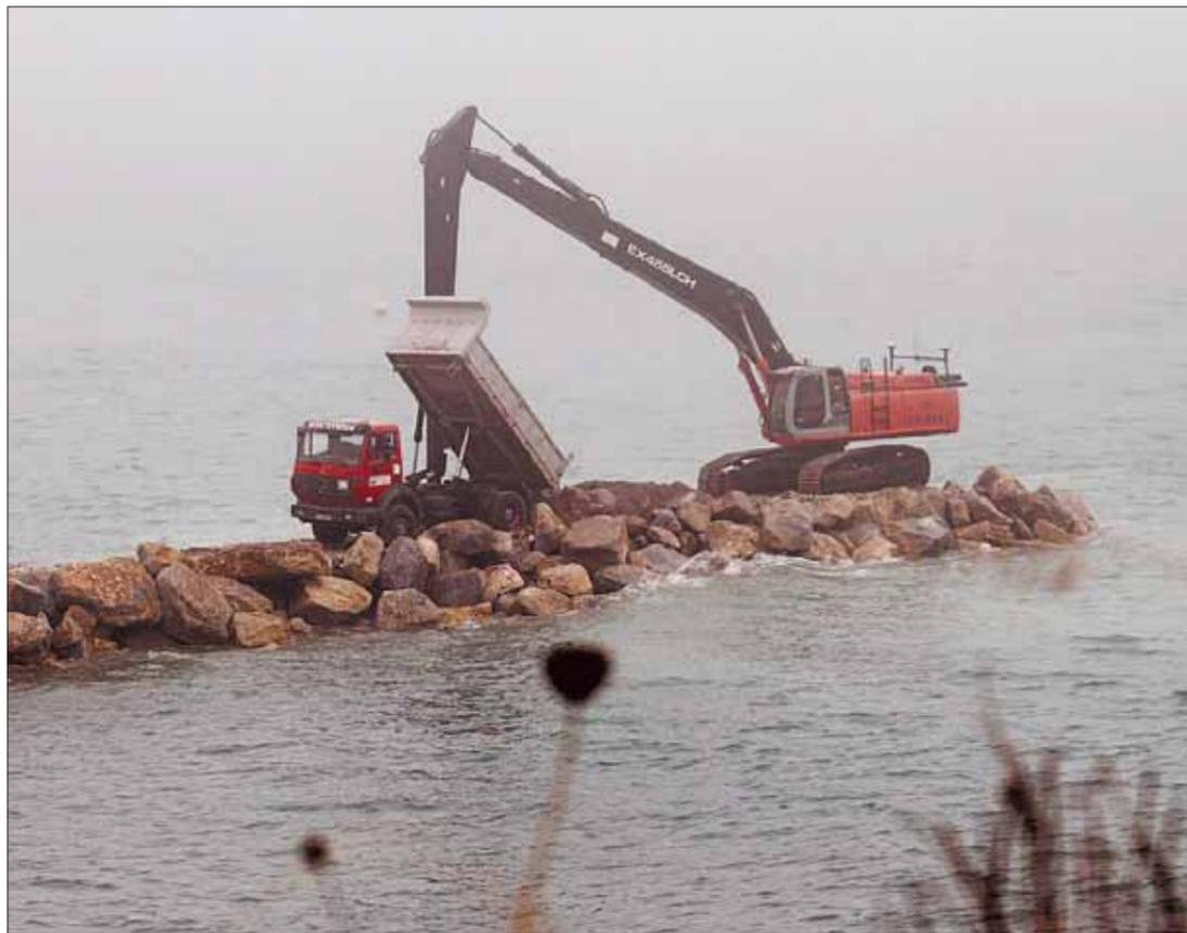
Labores de construcción de un segundo espigón efectuadas en la casa este del Peñón para ganar terreno al mar. / EFE
