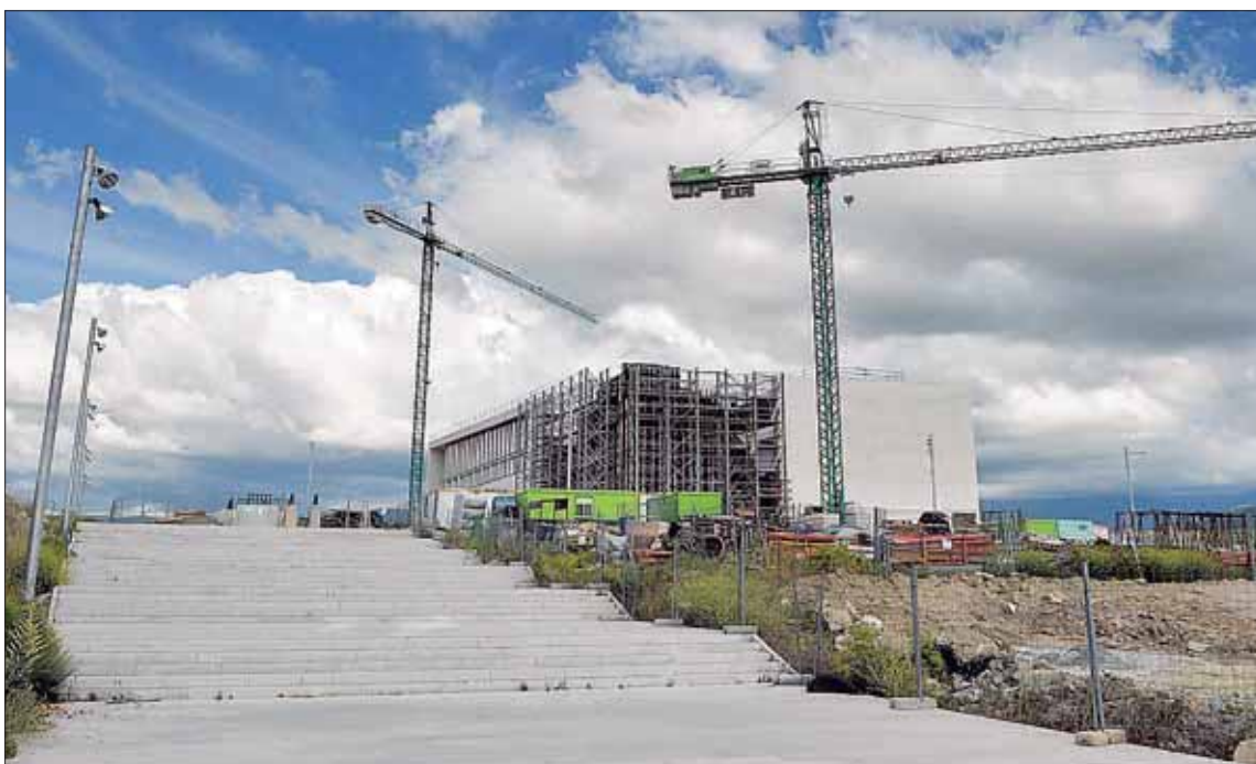
Las obras en el edificio de emprendedores se paralizaron hace ya dos meses por la situación de Volconsa. / KAMARERO
