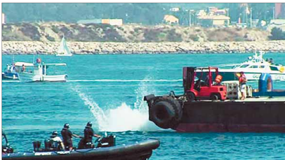
Hace varias semanas las autoridades gibraltareñas permitieron el lanzamientos de hasta 70 bloques de hormigón al mar.
