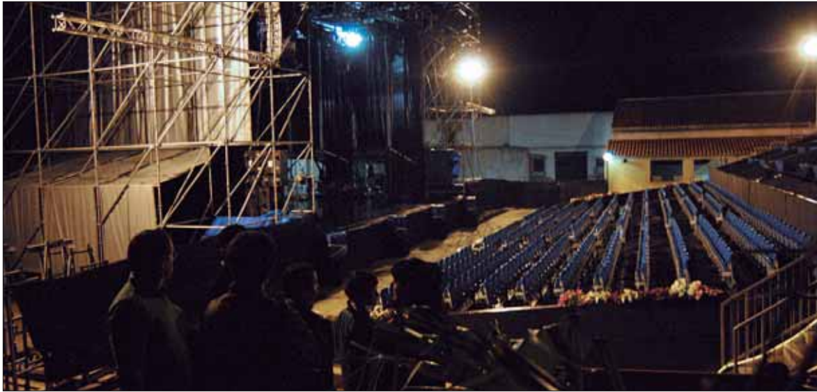
Aspecto del patio central de la Real Fábrica de Cristales al poco tiempo de anunciarse la suspensión. / ALBERTO BENAVENTE
