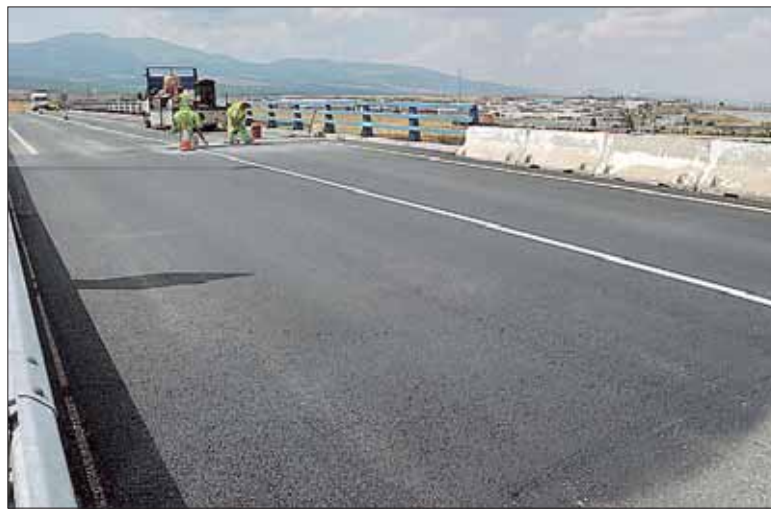
La actuación se centra en el puente existente en la vía. / KAMARERO
