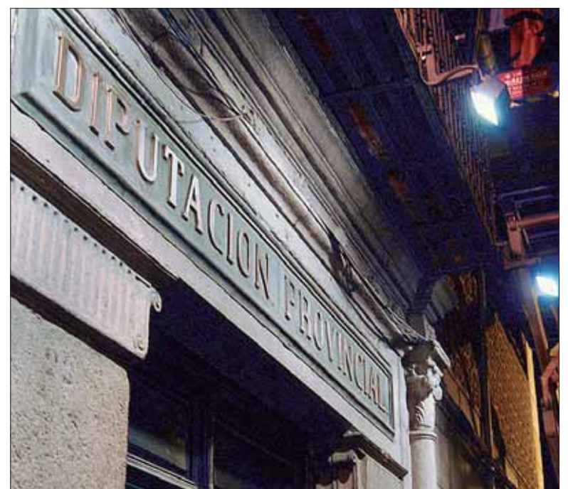
La Diputación generará planes de mejora de alumbrado en edificios. / KAMARERO
