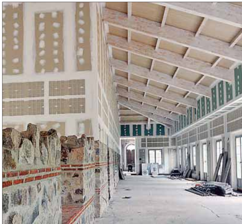
Interior del inmueble donde se ubicará el Palacio de Congresos. / KAMARERO
