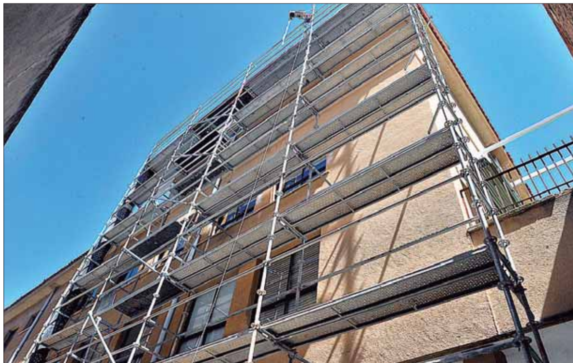
La intervención en la cubierta del colegio Domingo de Soto ha sido iniciada por parte de la Dirección de Educación. / KAMARERO
