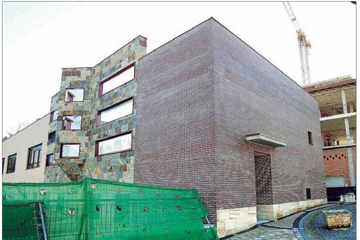
Imagen de archivo de la construcción de la Escuela de Educación Infantil del Ayuntamiento de Segovia. / A. BENAVENTE
