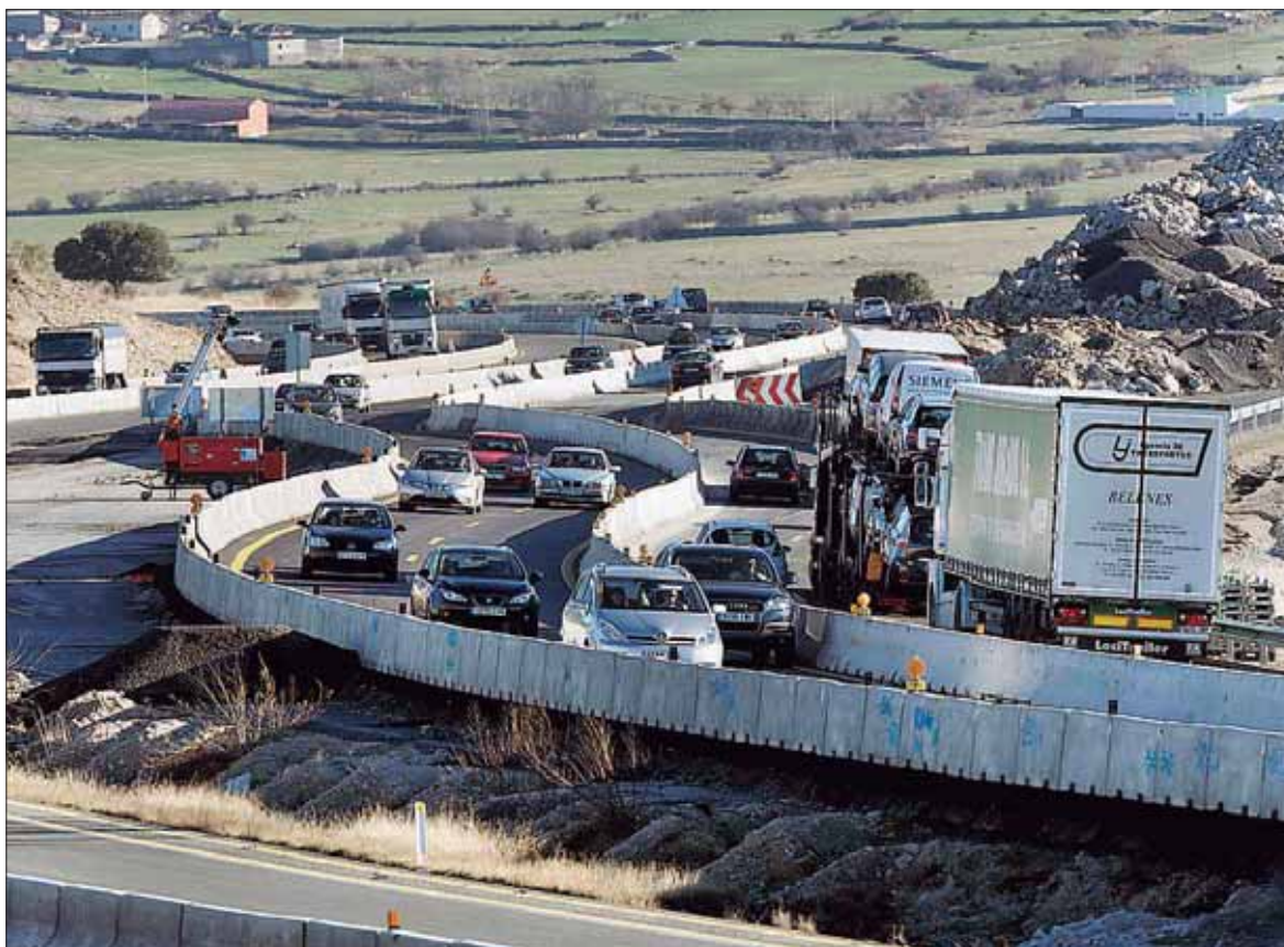
La autopista cuenta ya con un tercer carril que mejorará la fluidez del tráfico. / PEDRO L. MERINO
