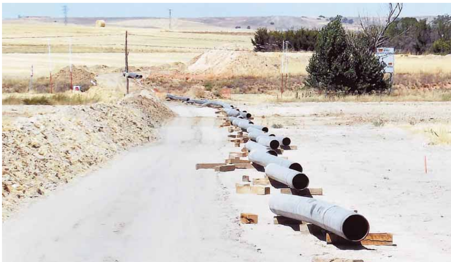
Estos días se llevan a cabo las obras de canalización de casi 70 kilómetros. En la imagen, último tramo del gasoducto, cerca del polígono industrial en Valverde. / F. D.
