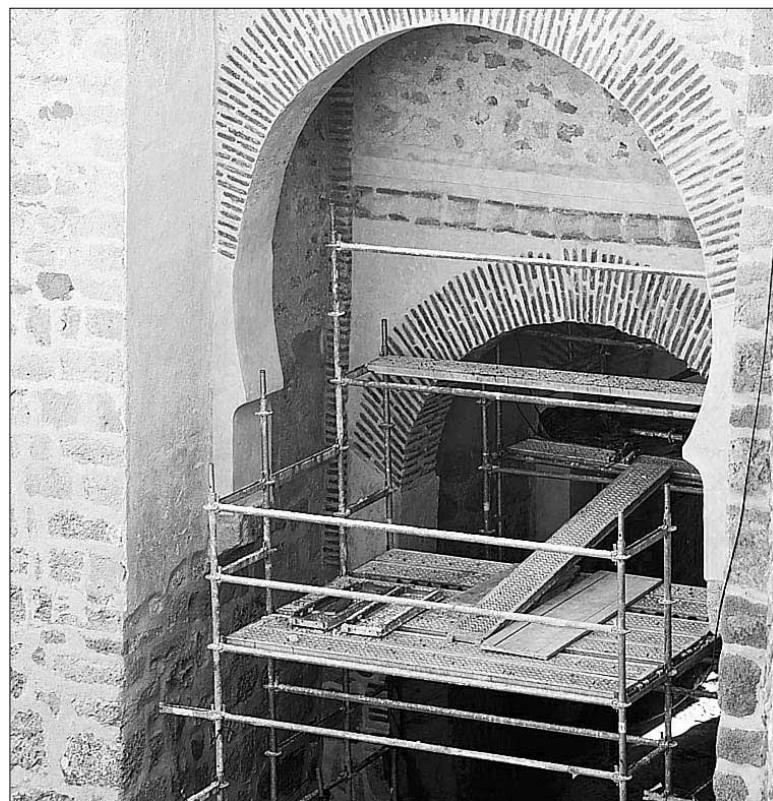
Arco de Santiago, en cuya rehabilitación participa esta fundación. / KAMARERO
