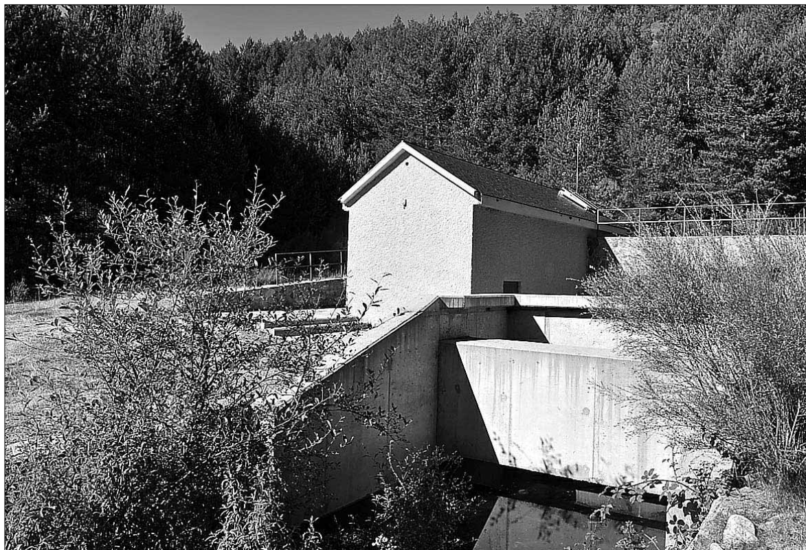
La directora general visitó la caseta de control del sistema de grifos de la presa del Tejo. / PEDRO L. MERINO
