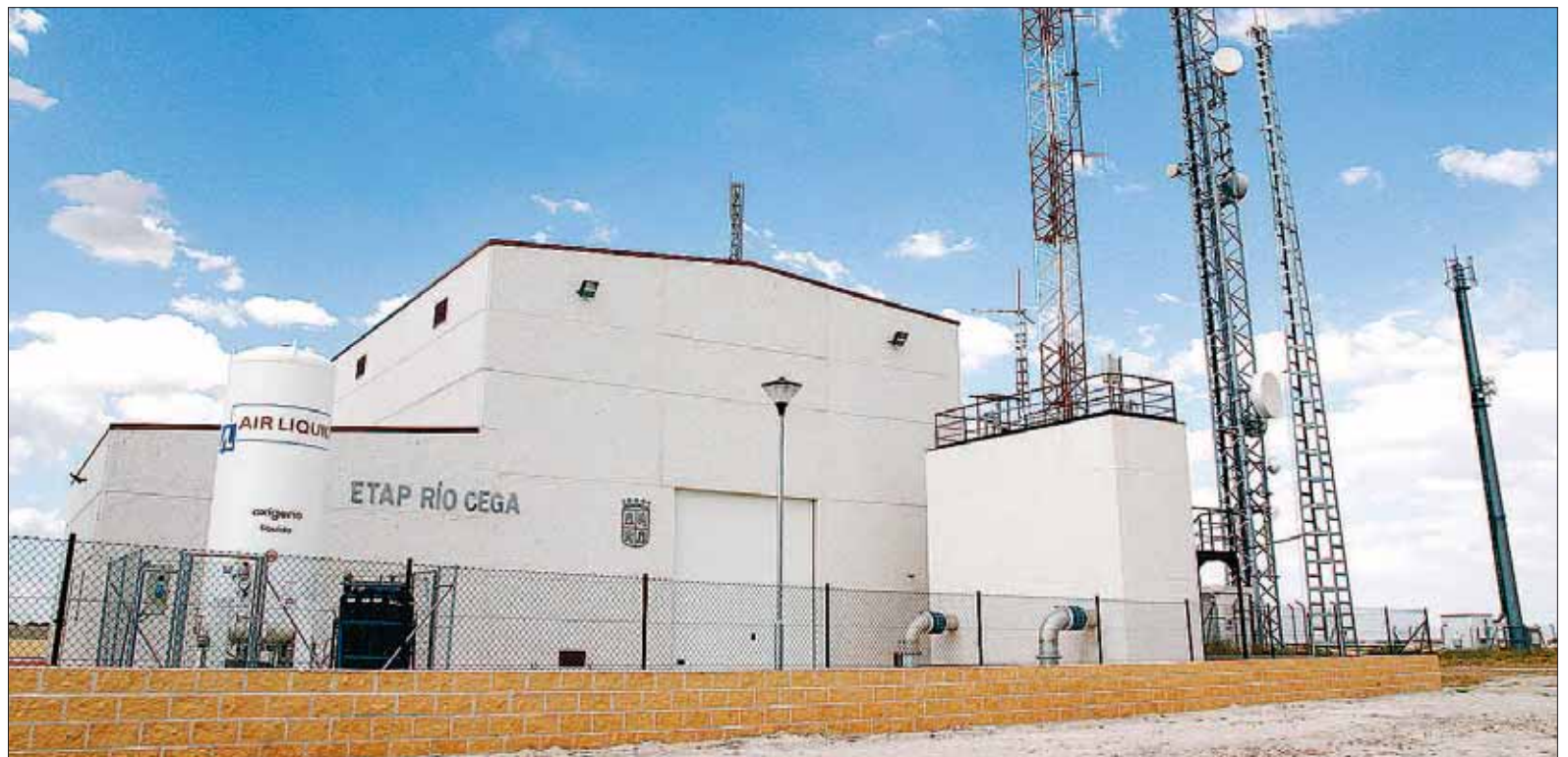
Estación de tratamiento de agua potable de Las Lomas, en Cuéllar, que gestiona todo el agua de la comarca del Carracillo. / GABRIEL GÓMEZ
