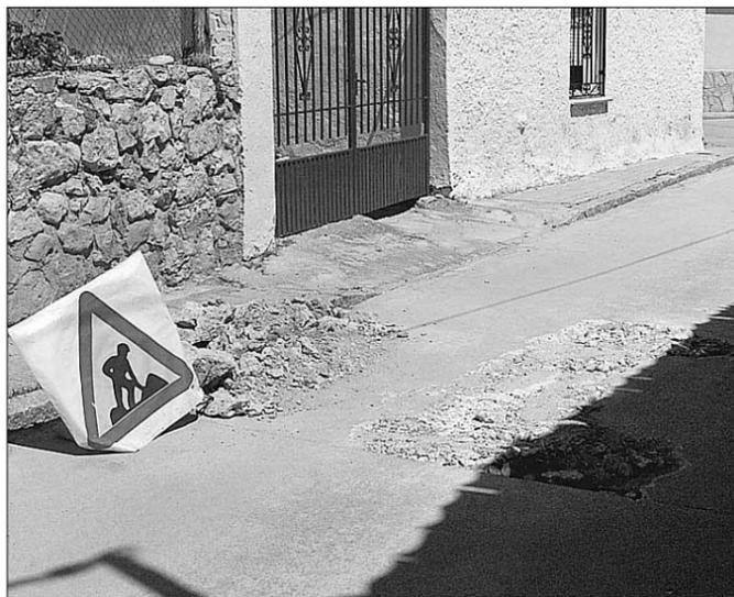
El pavimento de una calle, dañado por la subida de presión del agua.
