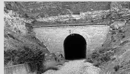
TÚNEL DE PEROGORDO A su entrada se pueden ver rocas formadas por acumulación de sedimentos del fondo marino que ocupaba esta zona hace 85 millones de años.
