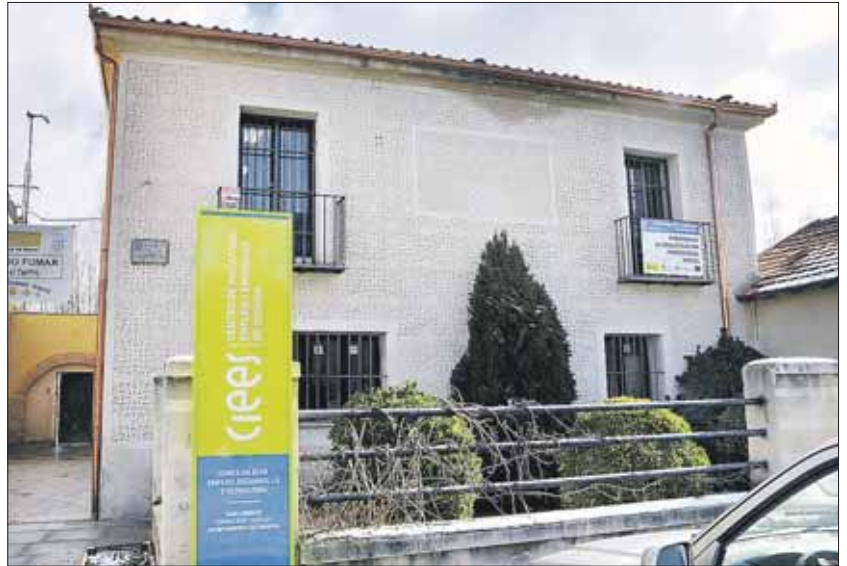
Foto de archivo de la sede del Vivero de Oficinas del CIEES, en el barrio de San Lorenzo. / ALBERTO BENAVENTE
