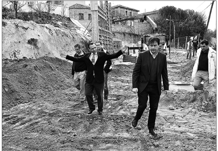
Arahuetes, en su visita a las obras, comentó que la nueva calle tendrá una anchura de más de 10 metros. / JUAN MARTÍN
