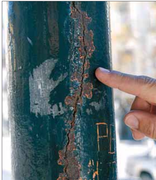
Detalle de otra de las fisuras detectadas en los pilares del kiosco. / JUAN MARTÍN
