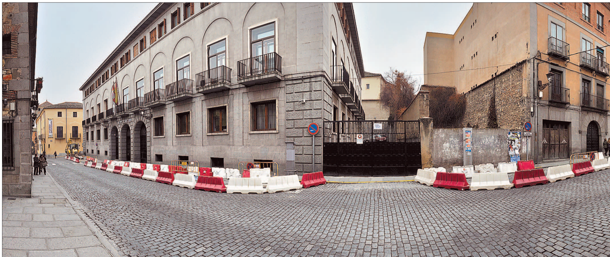
El arranque de las obras se manifestó en la delimitación de la primera zona de actuación, con vallas y pivotes de plástico. La excavadora, ya aparcada en la zona, comenzará hoy a levantar los primeros adoquines de la calzada.
