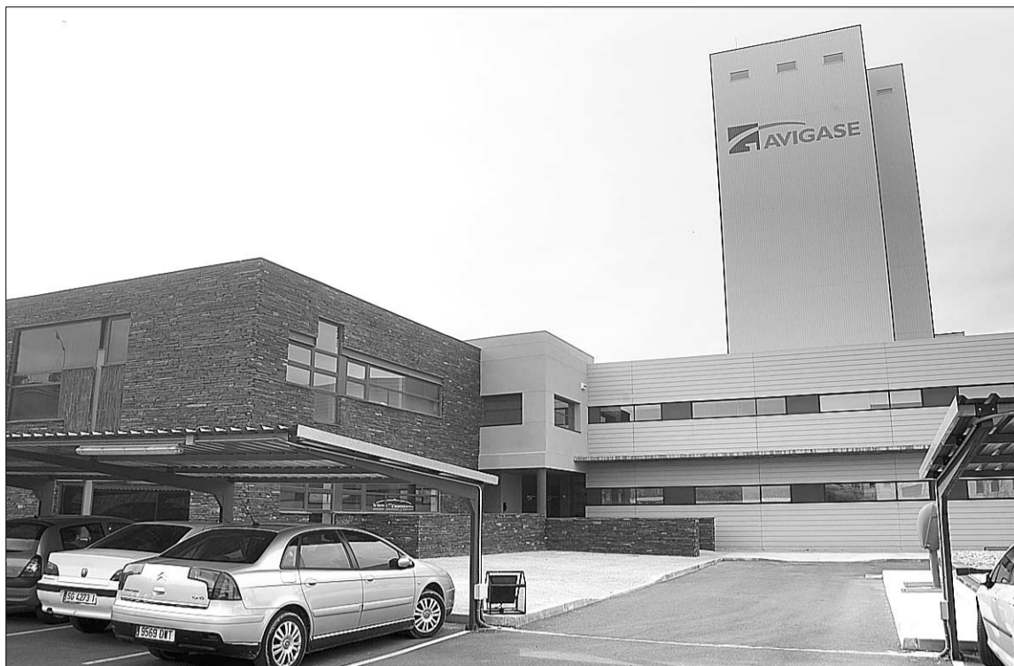
Instalaciones de Avigase, la cooperativa más grande de las segovianas integradas en Urcacyl. / KAMARERO
