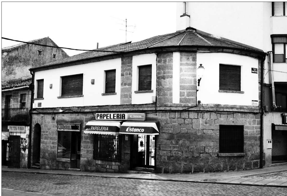
Imagen del inmueble al que accedieron los ladrones haciendo un butrón en el suelo desde la planta superior. / PEDRO L. MERINO
