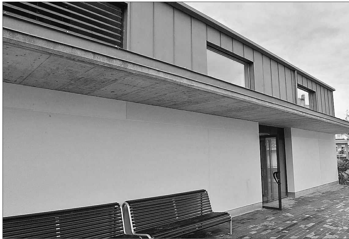
El nuevo consultorio de La Lastrilla está a punto para entrar en funcionamiento. / KAMARERO
