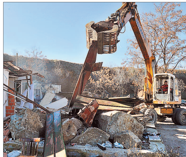
Una maquina excavadora procedió a derribar la última infravivienda. / KAMARERO
