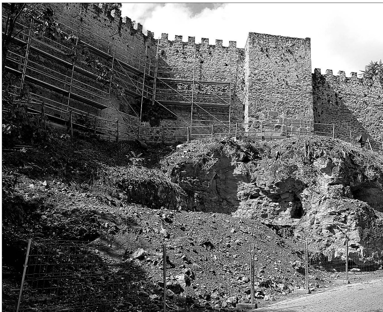
La empresa Alvac está trabajando en la limpieza y consolidación del tramo de muralla entre los cubos 37 y 43, junto a la Puerta de San Ceberio
