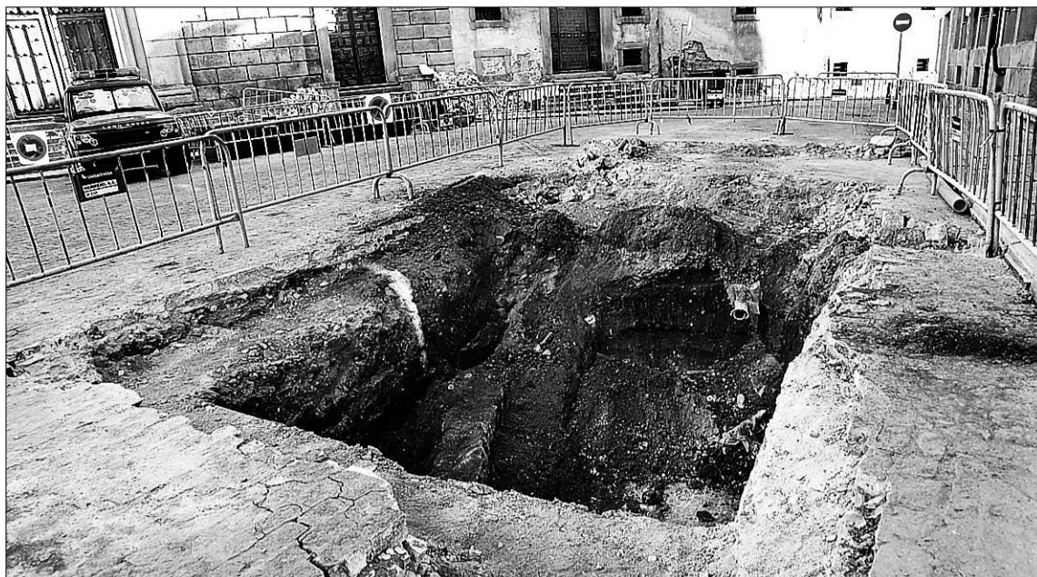
Los trabajos de excavación se encuentran en la parte trasera de la Delegación Territorial de la Junta. / DIEGO DE MIGUEL
