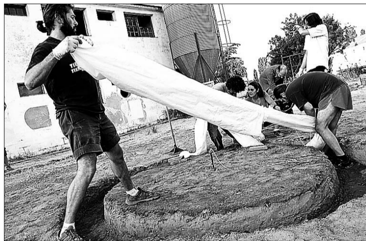
Alumnos y formadores construyendo el pequeño refugio. / GABRIEL GÓMEZ
