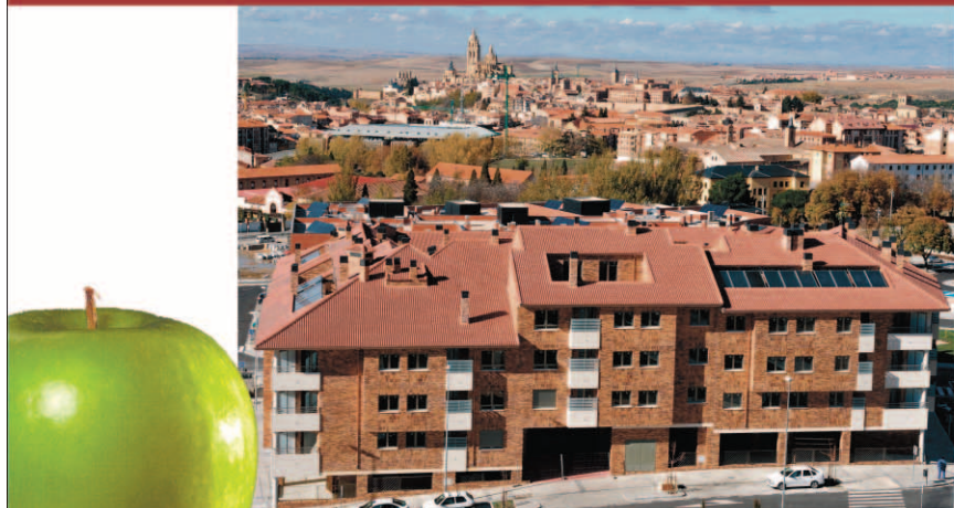
"MANZANA GOLDEN", Edificio de 86 viviendas, locales, garajes y trasteros.
