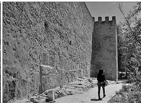
La muralla ha sido restaurada al completo. / KAMARERO
