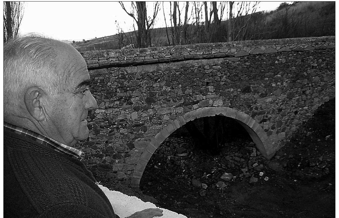
El alcalde, Gregorio Allas, junto al acueducto de El Zancao, próximo al parque etnográfico de Los Hornos. / ÁLVARO PINELA
