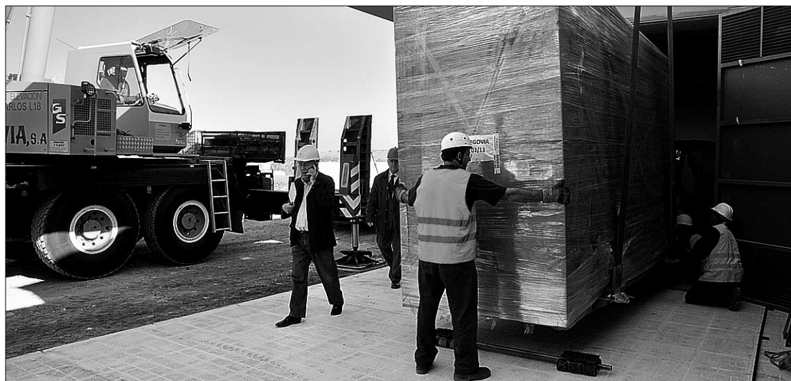
El horno del futuro crematorio llegó ayer a las nuevas instalaciones que construye Agencia Funeraria Santa Teresa. / A.S.
