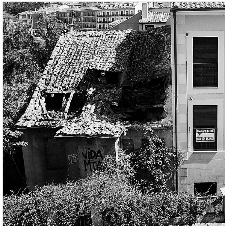
El edificio que será derribado se sitúa en el número 4 del Paseo de Santo Domingo./ A.K.
