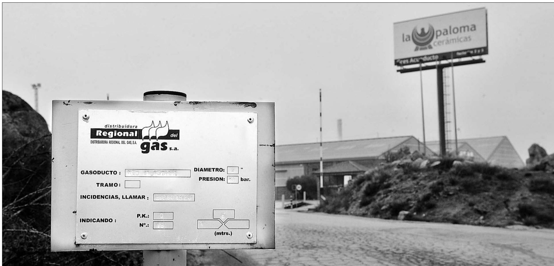
La Paloma, que será uno de los principales usuarios del gas natural de Otero de Herreros, está acondicionando sus instalaciones. /KAMARERO
