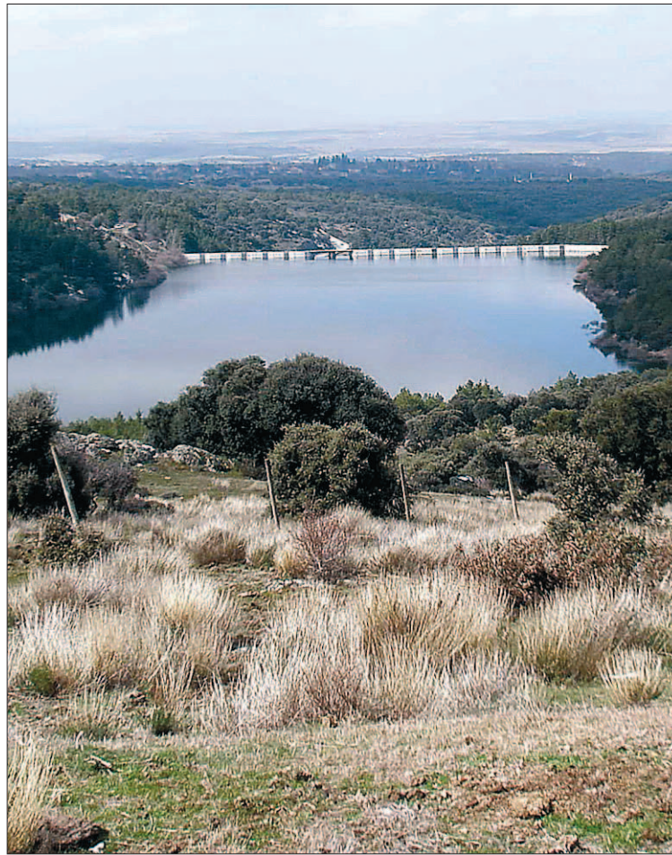
El embalse de Puente Alta, en la entidad local menor de Revenga, de titularidad municipal, se construyó en la década de los años 50. / J. MARTÍNEZ
