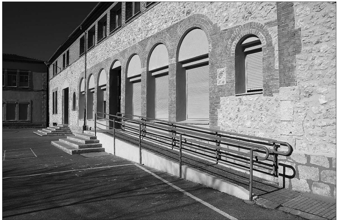
Estado actual de la fachada de La Villa tras las obras de restauración realizadas en las vacaciones navideñas. /GABRIEL GÓMEZ
