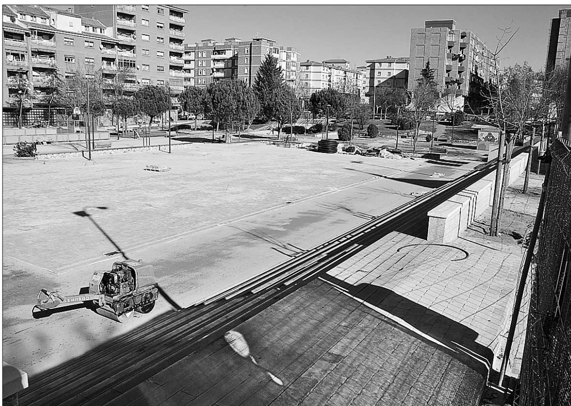
El Parque del Peñasal, en una imagen tomada este fin de semana. Las obras terminarán en unos días. / JUAN MARTÍN
