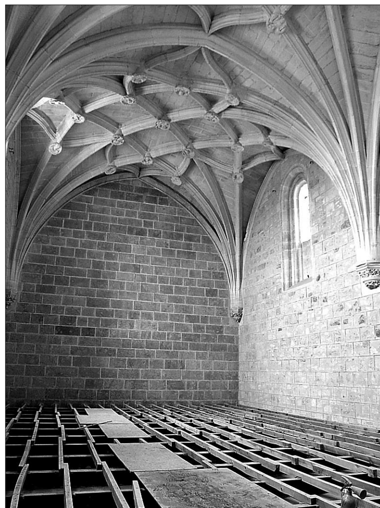
La cubierta de la zona de la librería ofrece ya un renovado aspecto. /A. BENAVENTE
