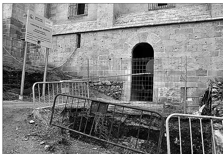
De arriba a abajo, un experto interviene sobre uno de los leones que adornan el muro perimetral y dos aspectos del trabajo en el muro y el talud. / A. BENAVENTE
