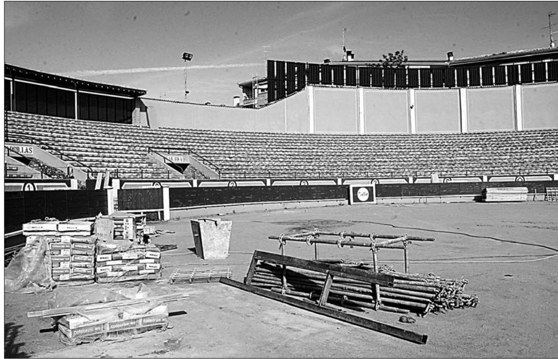
Estado actual de los trabajos de acondicionamiento de la plaza de toros de la villa. / GABRIEL GÓMEZ
