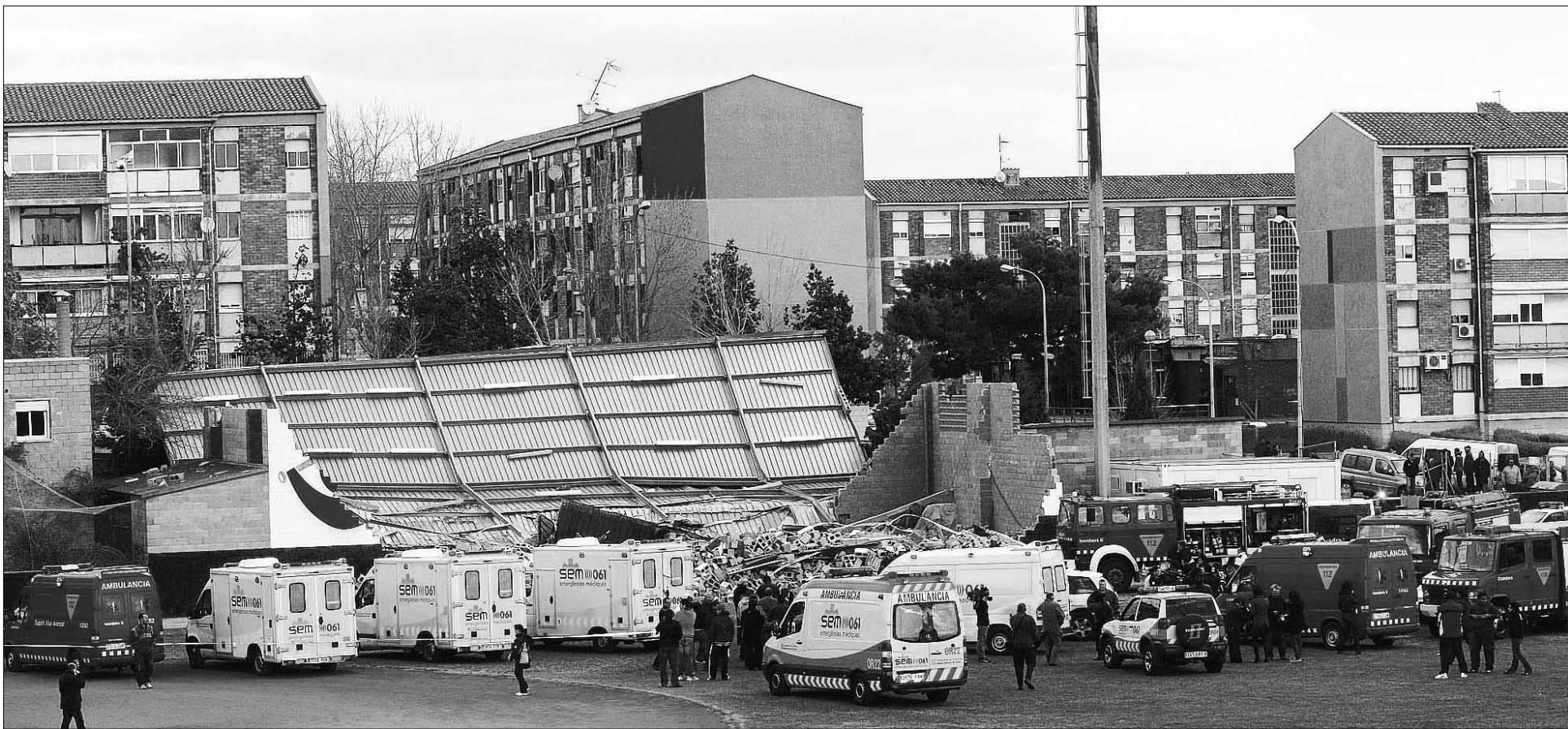
En este estado quedó la instalación deportiva de Sant Boi de Llobregat tras el derrumbe en el que murieron cuatro niños, de entre nueve y 12 años. / ALBERT GEA (REUTERS)
