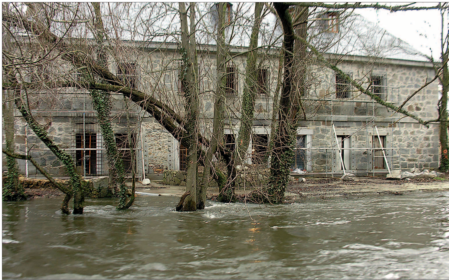
El agua estaba ayer a punto de superar la plataforma proyectada para la futura terraza del restaurante que albergará la Casa de la Moneda. /EL ADELANTADO
