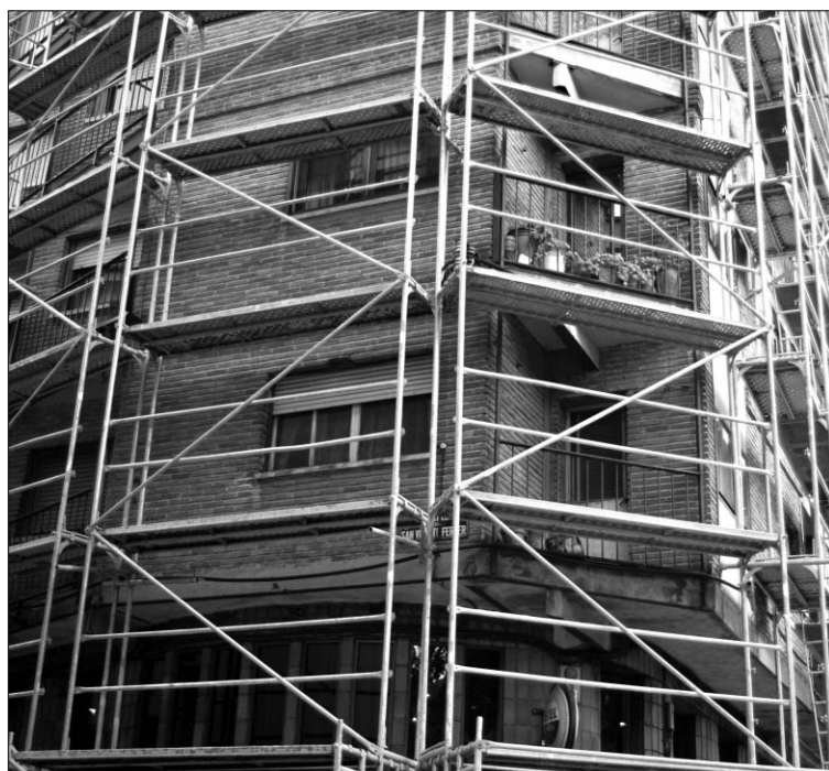
Acometer nuevas obras o rehabilitaciones resulta un poco más complicado. / KAMARERO
