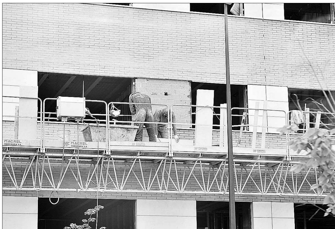
Viviendas en construcción en Segovia. El sector inmobiliario es uno de los más afectados por la crisis. / KAMARERO
