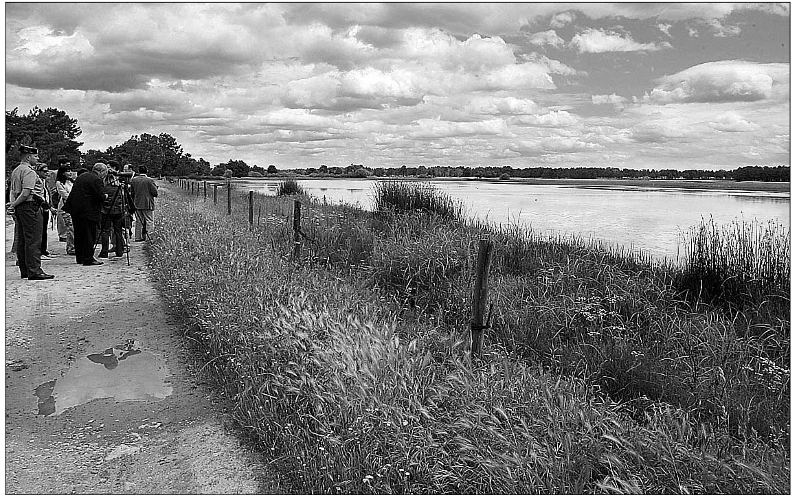
Los cerramientos con los que estaban protegidas las lagunas han sido ya retirados por las empresas. / PEÑALOSA
