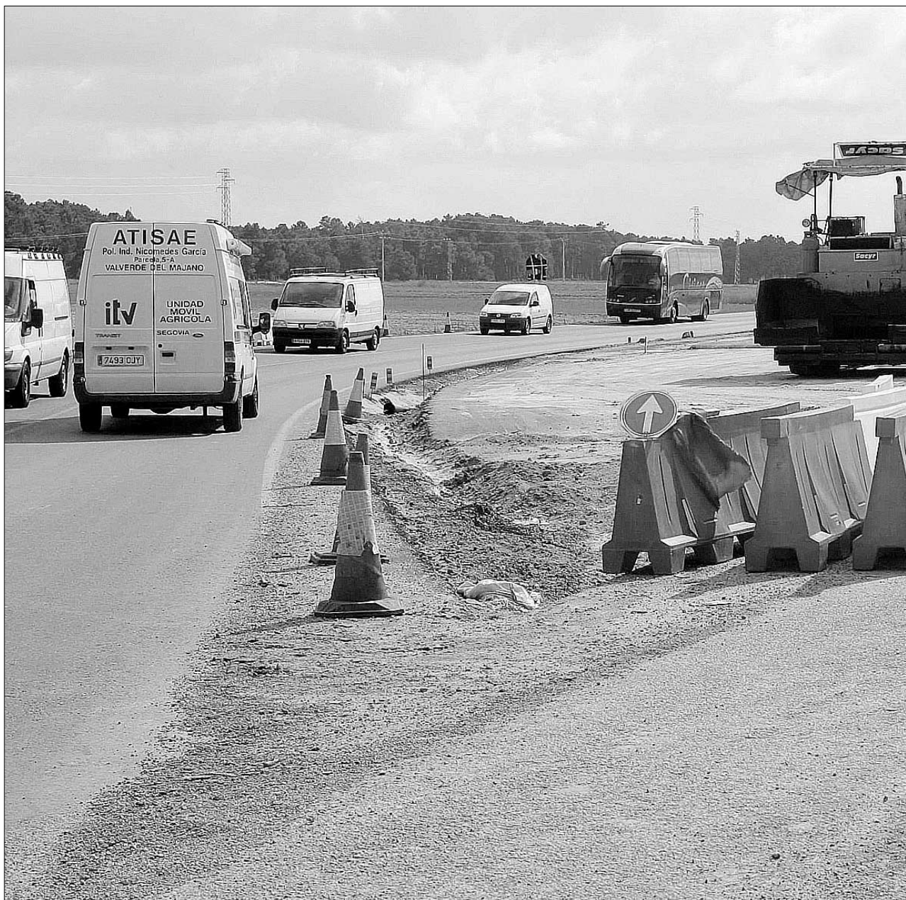
Las obras de conversión de la CL-601 en autovía comenzaron hace varios meses, divididas en dos tramos, y se prevé que estén finalizadas
