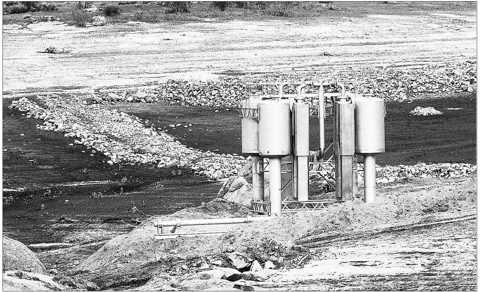
La nueva infraestructura tomará el agua de la superficie del embalse, lo que permitirá que la calidad del suministro sea mejor, según la CHD. / KAMARERO
