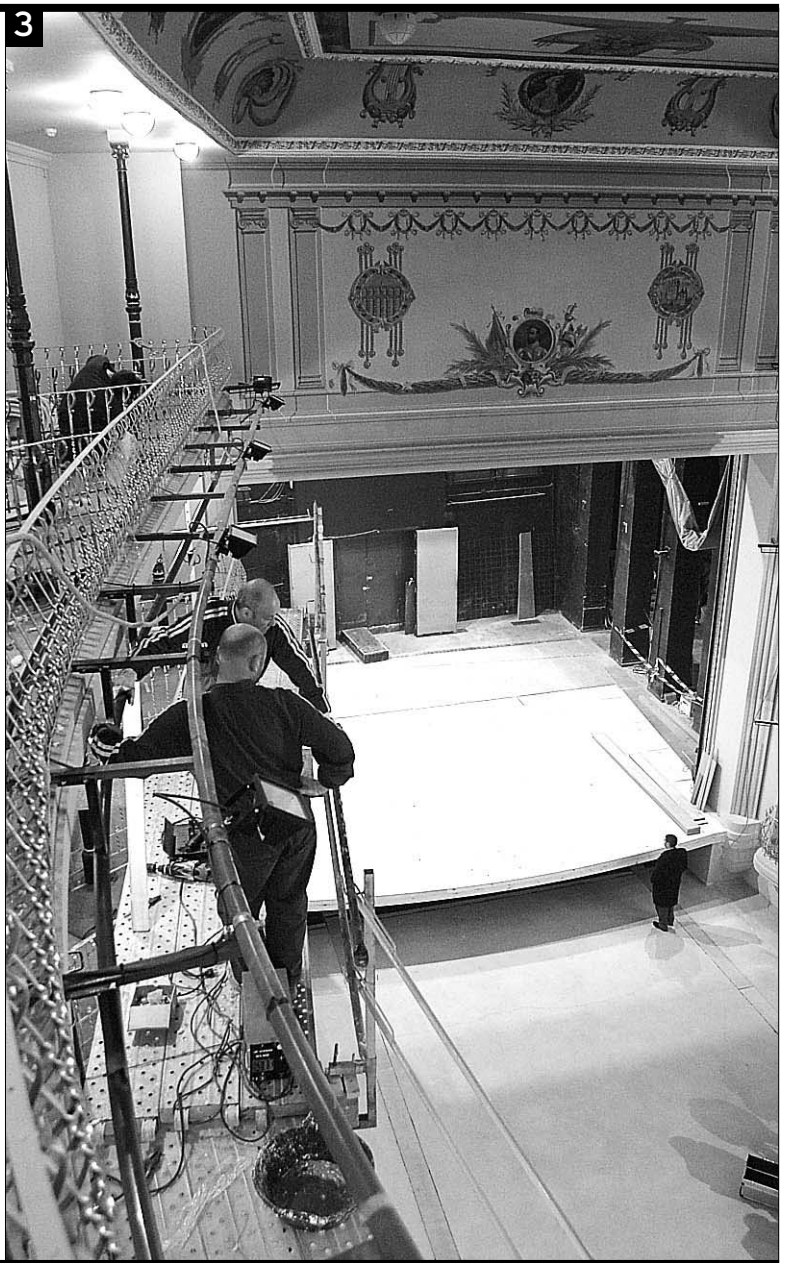
1. Andamios colocados en el vestíbulo donde se están cambiando condiciones del sistema eléctrico y de climatización. 2. Vista desde el escenario hacia los palcos. 3. Las barandillas están siendo pintadas con tonos dorados y en el escenario se ha instalado un suelo de madera. / J. Martín
