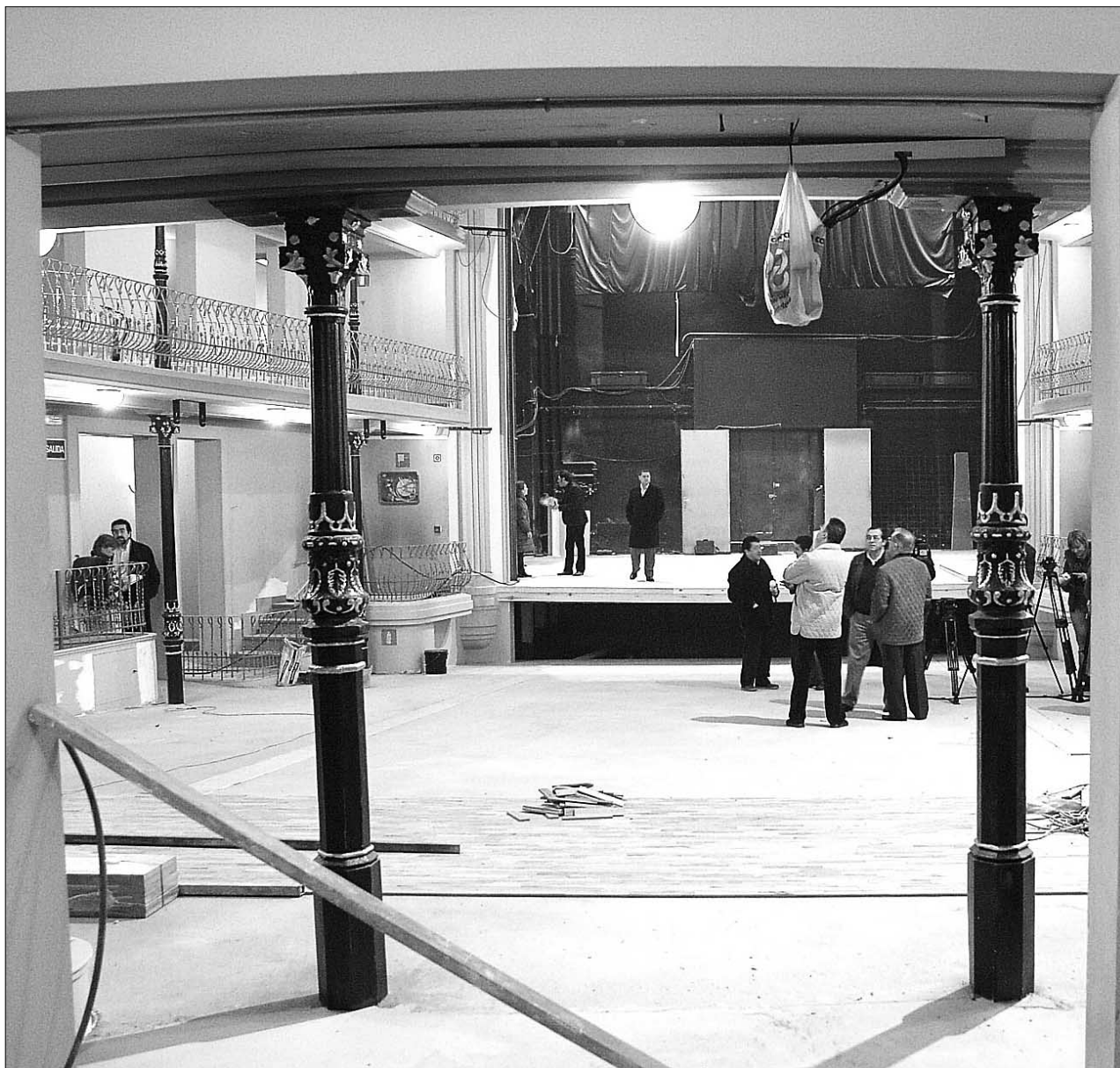
Imagen de la principal sala del teatro libre de la presencia de butacas. Los trabajadores de los servicios de la Diputación se han unido al equipo d
