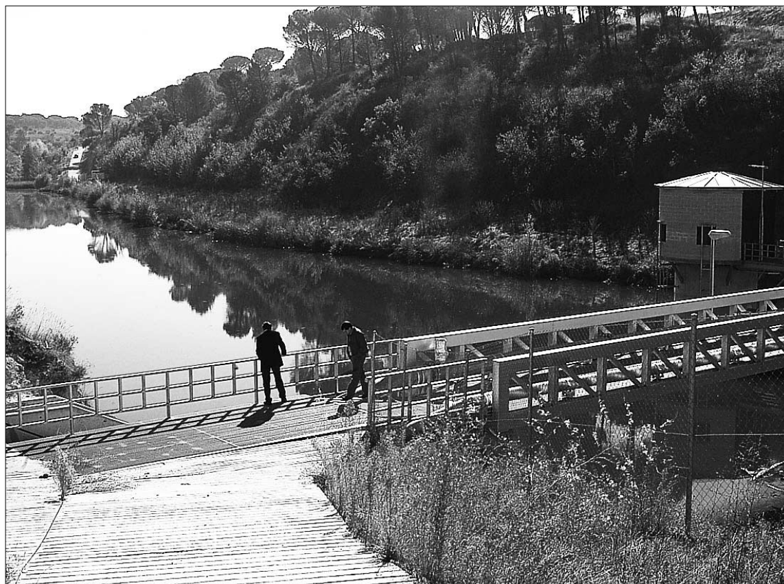
Vista del azud que suministra a la ETAP de Coca, que se sitúa en el término municipal de Villeguillo. / G. HERRERO
