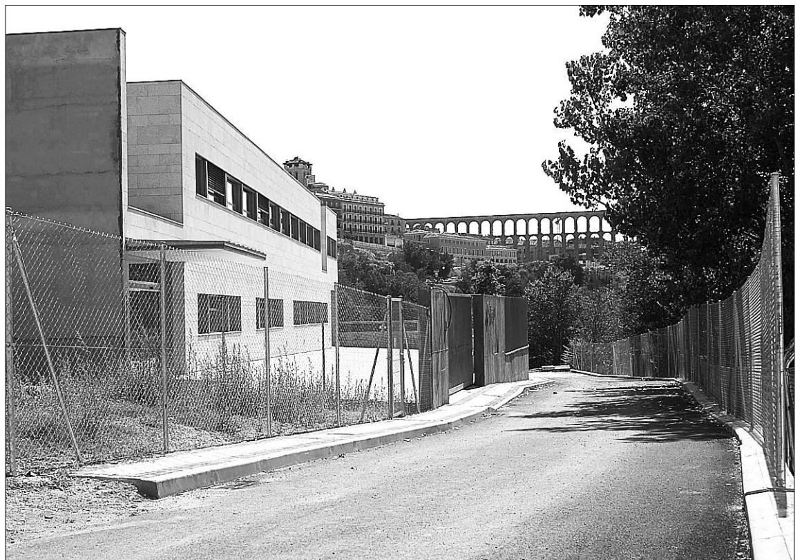
El acceso al nuevo centro de salud Segovia III se realiza por la calle Los Novillos. / JUAN MARTÍN
