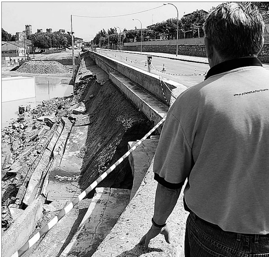
El derrumbe del graderío ha afectado también a la carretera que pasa junto al campo de fútbol./JUAN MARTÍN
