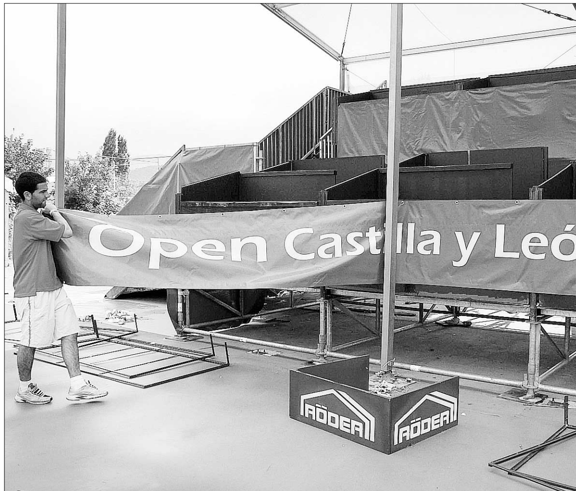
Imagen de uno de los chicos de mantenimiento desmontando la zona de palcos de la pista central. / PEDRO MERINO
