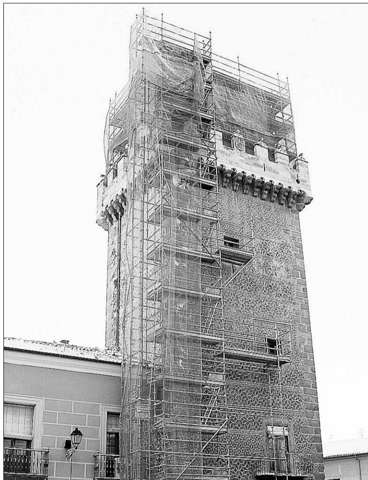
Los andamios permanecerán en la torre casi hasta finales de año. / KAMARERO
