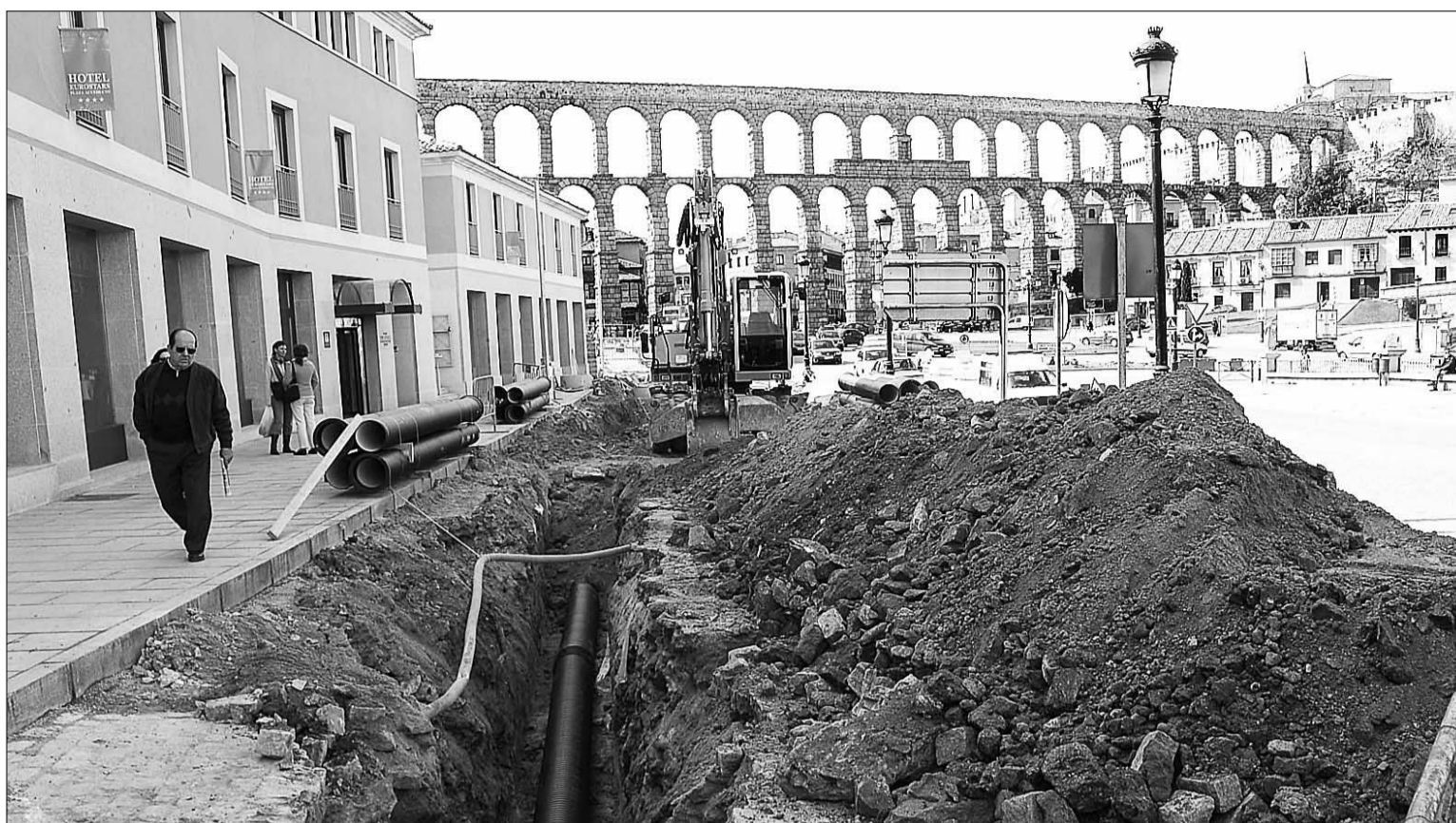
Actualmente los trabajos se dirigen a desviar la canalización de abastecimiento de agua de la zona que será afectada por la excavación/KAMARERO
