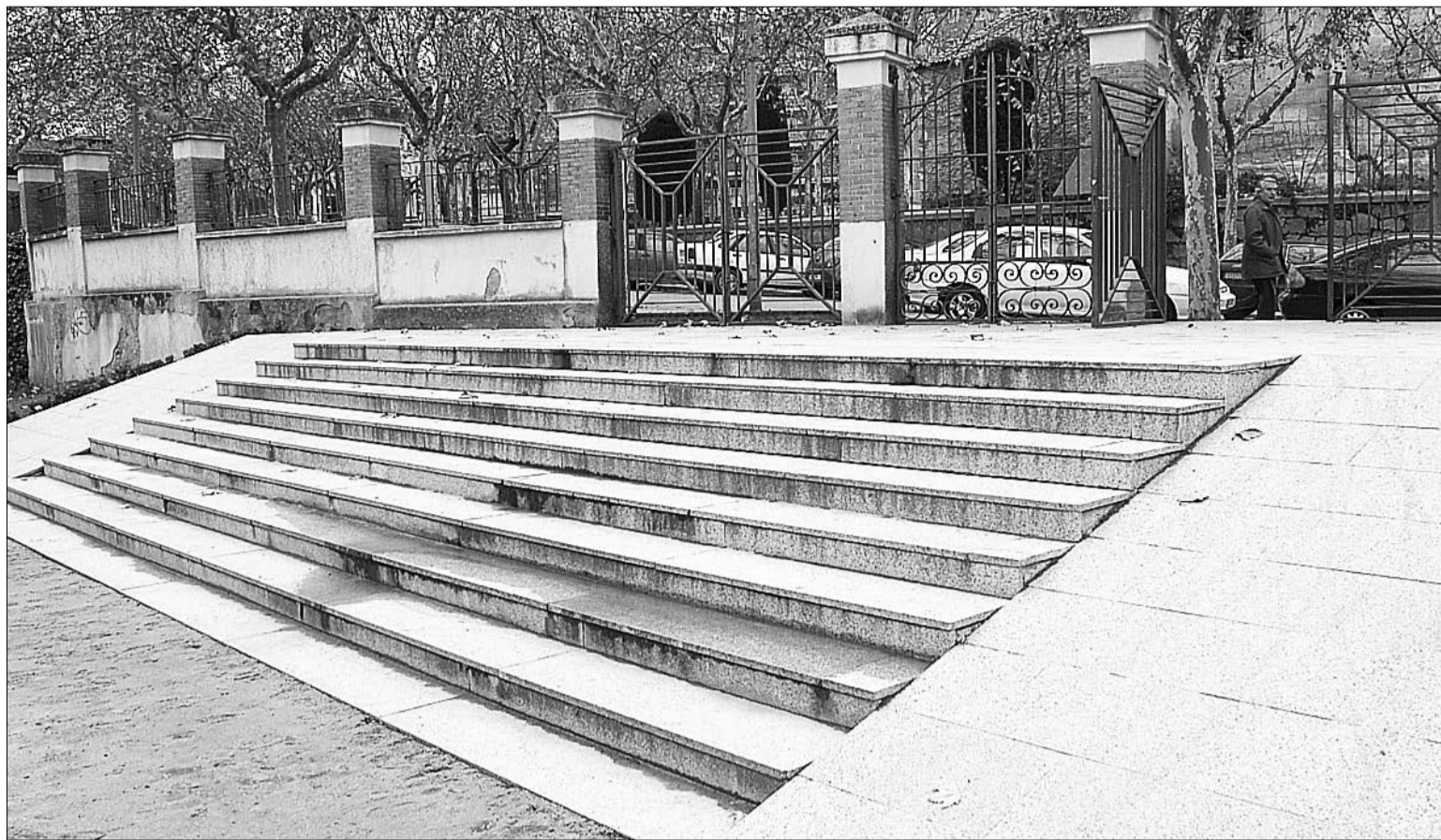
Imagen de la escalinata de acceso principal al Jardín Botánico desde la calle de Santo Tomás. Las obras en el Jardín se han prolongado tres meses./EL ADELANTADO
