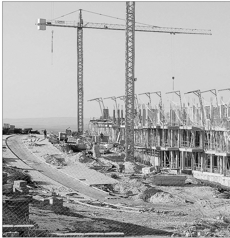
La construcción de las viviendas va muy avanzada, al igual que la realización de los viales. /KAMA
