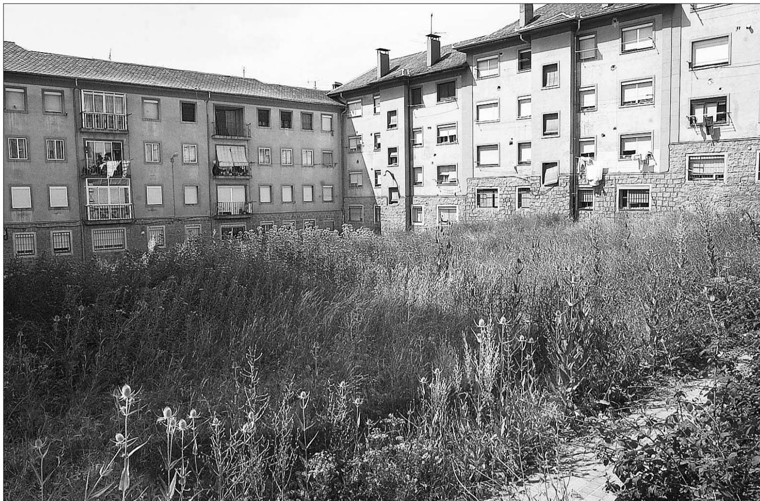
Las obras en los patios del barrio de San José consistirán en su limpieza, desbroce, mejora del suelo, arreglo del pavimento y trabajos de jardinería. / JUAN MATÍN
