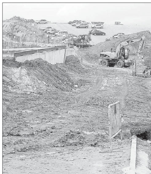
Trabajos en el exterior del Hospital General. KAMARERO
