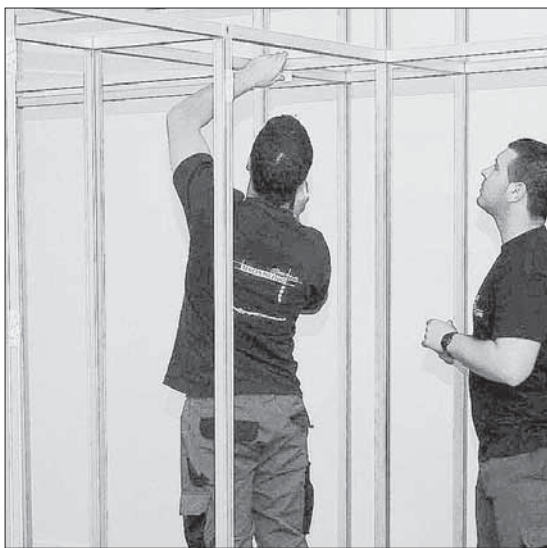
Los encargados del montaje instalaron los paneles./PABLO MARTÍN
