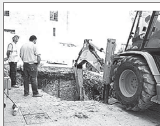
Obras de soterramiento en San Nicolás/J.M.
