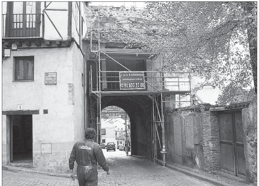
Imagen del andamio que fue instalado en la mañana de ayer para acometer la reparación del camarín de la Virgen/JJ.MARTÍN
