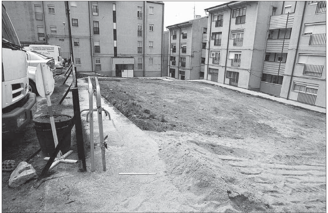
Las mejoras en las dos plazas del barrio de El Palo, deterioradas por el paso del tiempo y la falta de mantenimiento, costarán más de 64.000 euros. / FERNANDO PEÑALOSA
