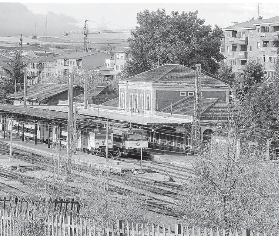
Obra en marcha de la parada del AVE, según afirmó ayer el subdelegado del Gobierno en Segovia. / FERNANDO PEÑALOSA
