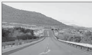
El Estado reforzará el firme de la N-603
