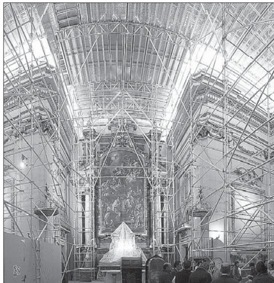
El interior de La Colegiata se encuentra lleno de andamios. / KAMARERO
